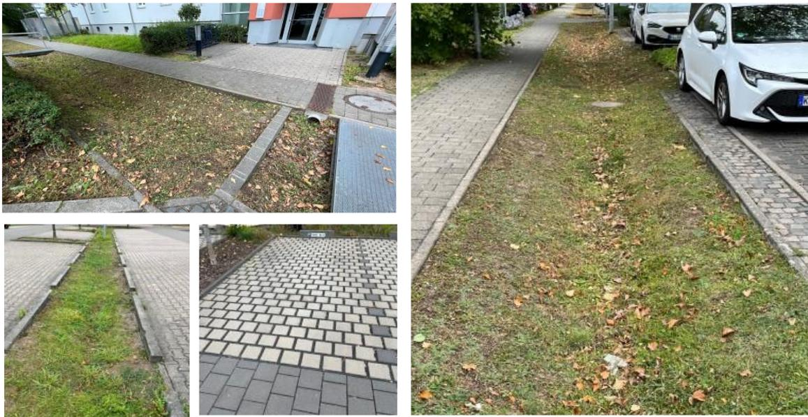
Abbildung 21: Versickerungsbetonte Entwässerungsstrukturen in der Bebauung
