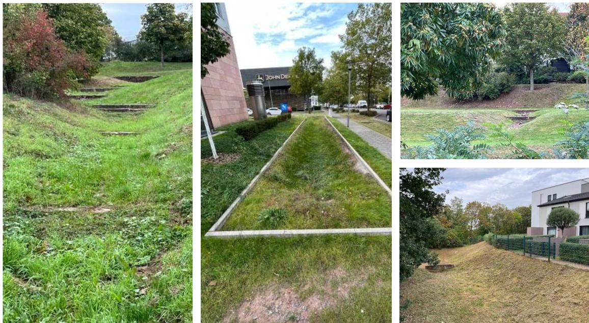
Abbildung 22: Dezentraler Regenwasserrückhalt mit Verdunstung und Versickerung „im Quartier“
